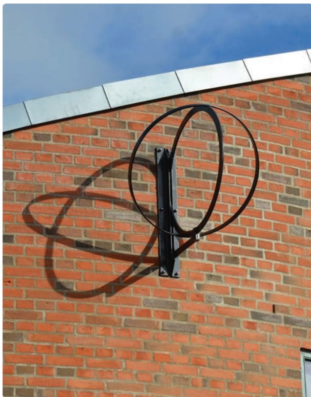
Figur 1 Armillarsfære på Morsø Gymnasium. Ved lokal middag er skyggen af den lodrette cirkel en lodret linje. Ved jævndøgn er skyggen af den skrå cirkel en vandret linje.
